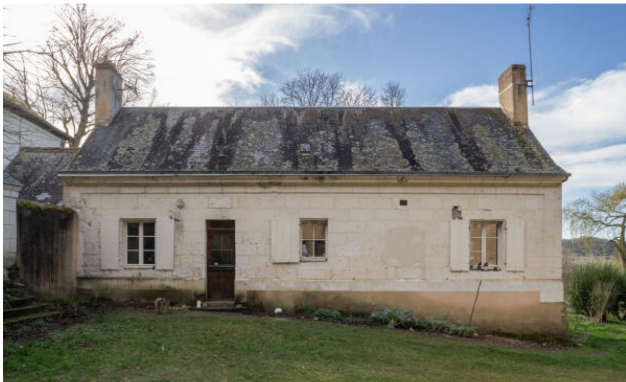
Logement de la ferme.
