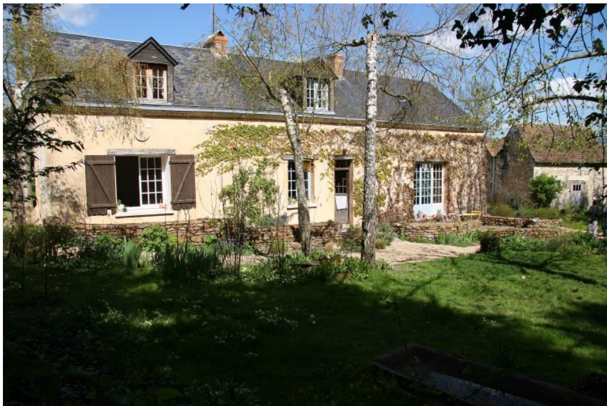
Vue d'ensemble de la maison.
