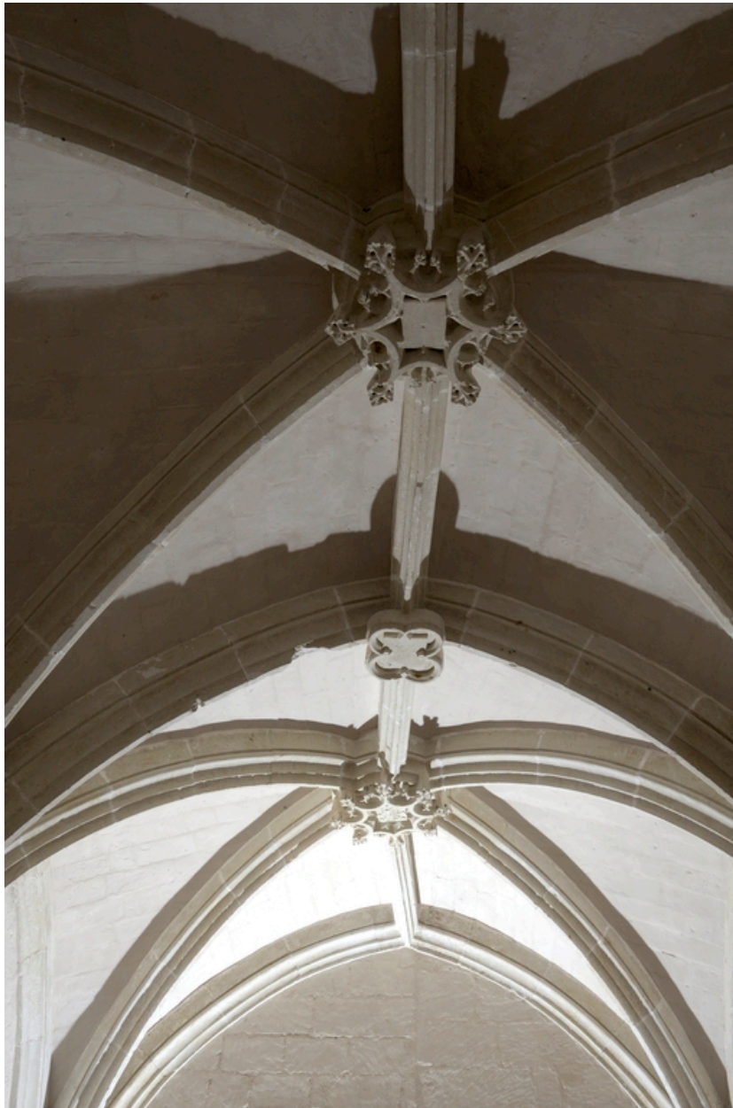
Ancienne chapelle nord (fin XVe siècle), étage. Voûte (après restaurations 2013).
