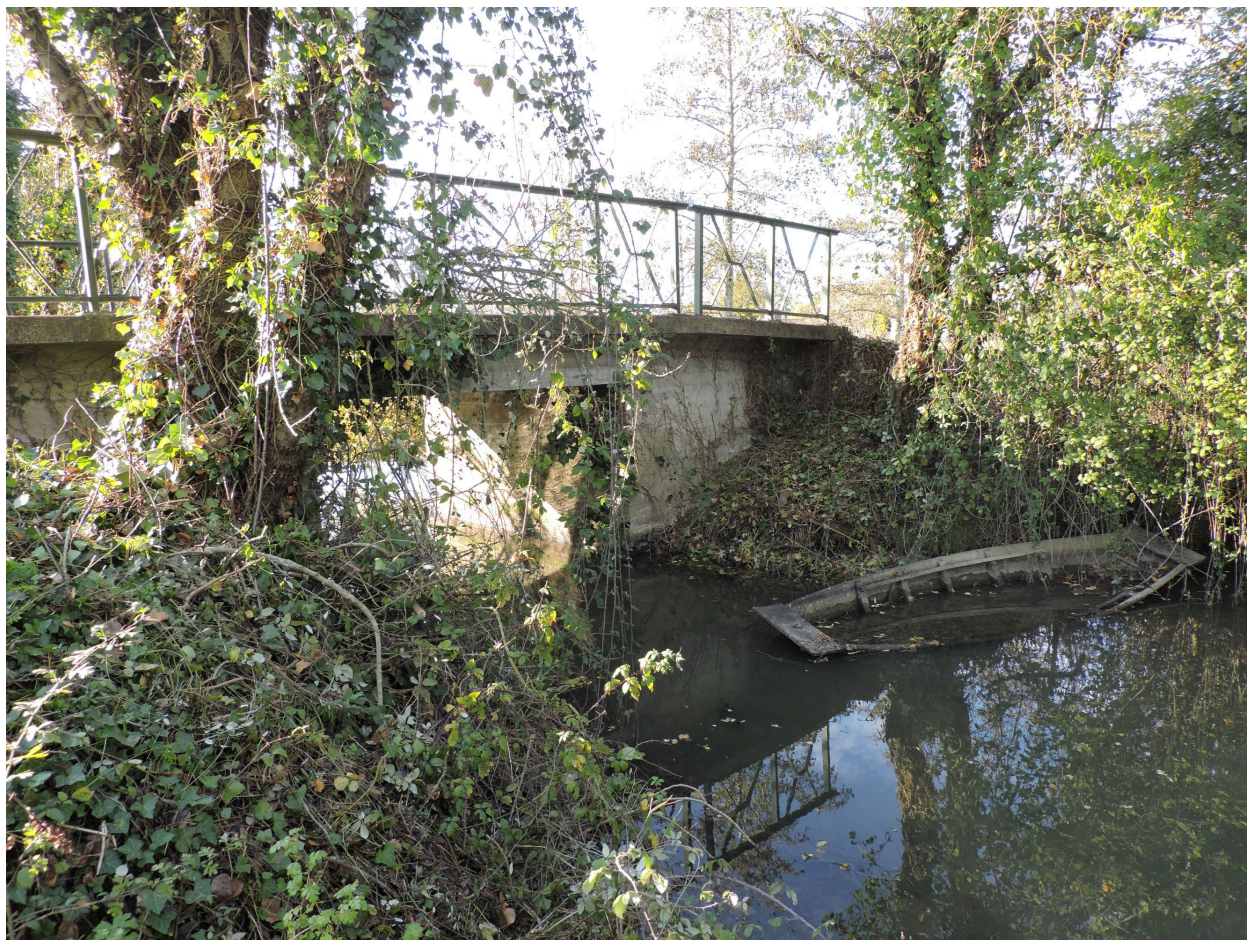
Le pont en amont, vu depuis le sud-est.
