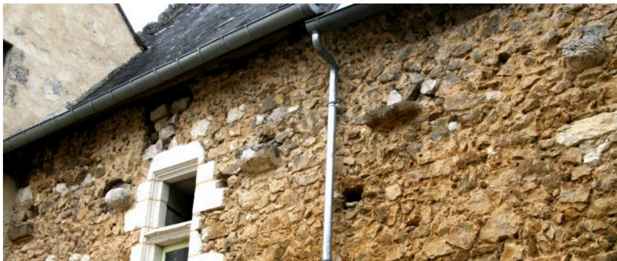
Façade sur cour : rangée de pierres alignées en saillie.
