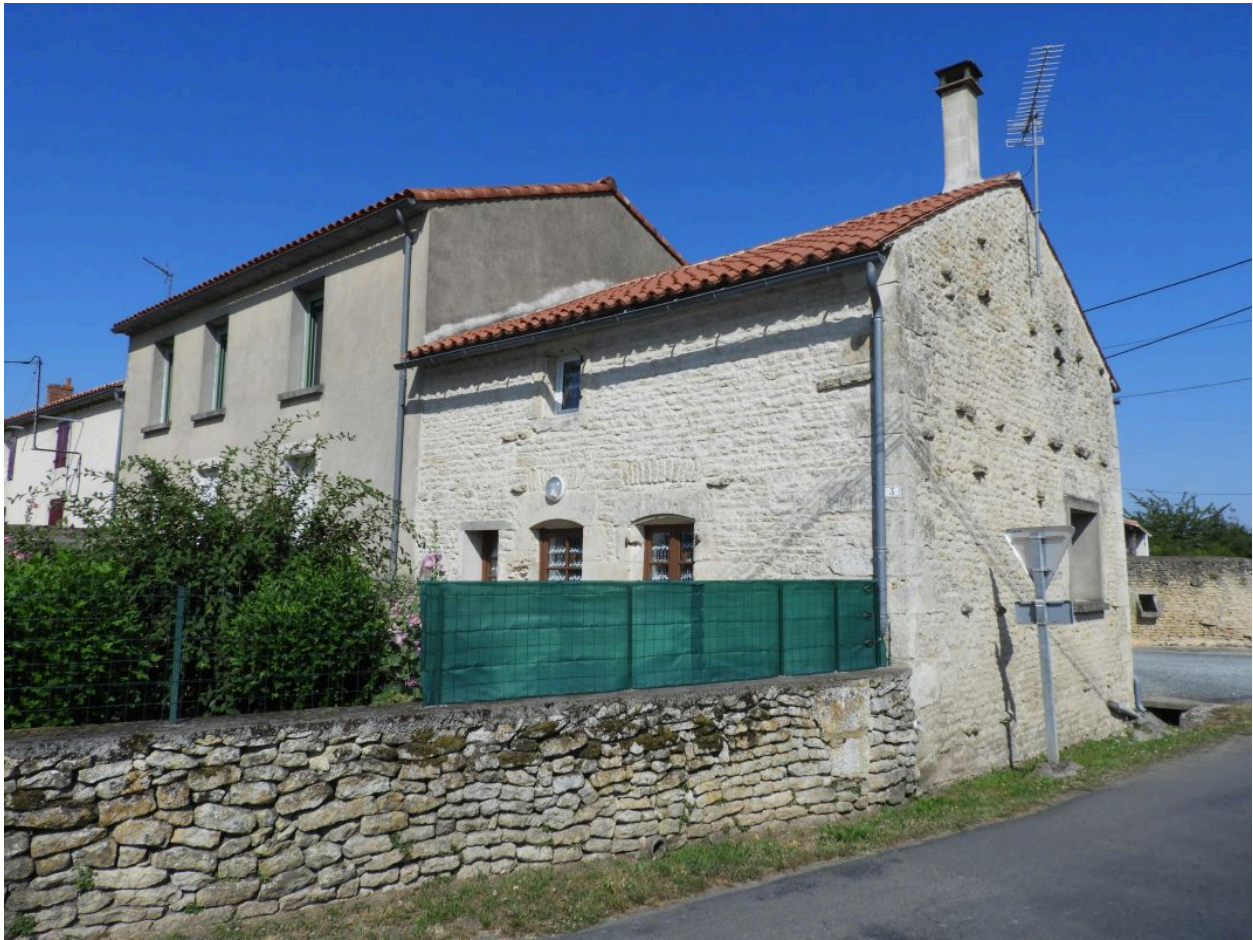
La maison du numéro 3 vue depuis l'est.
