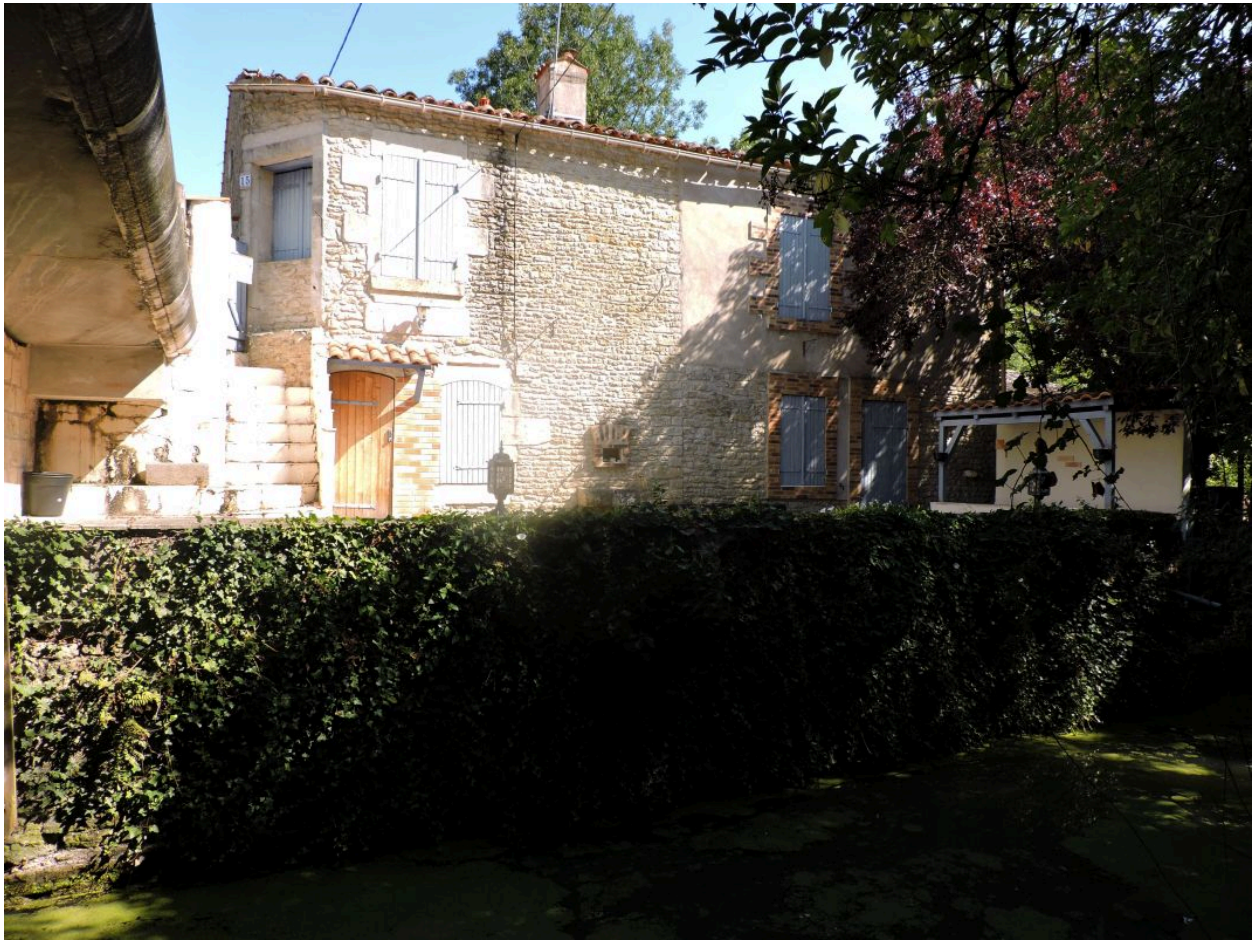
La maison, au bord du canal de Vix, vue depuis le sud.
