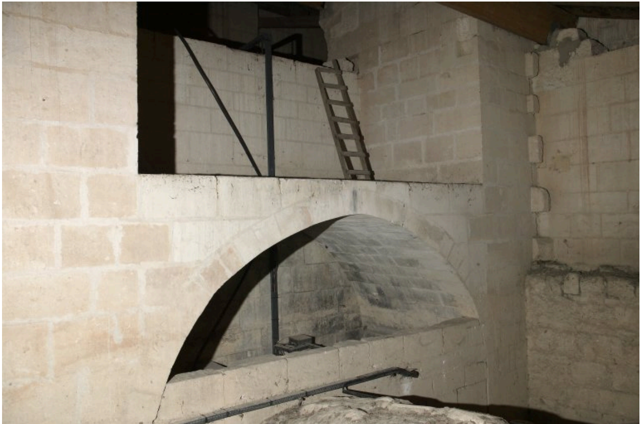
Vue prise des combles de la sacristie, montrant le mur extérieur du bas-côté sud du chœur.
