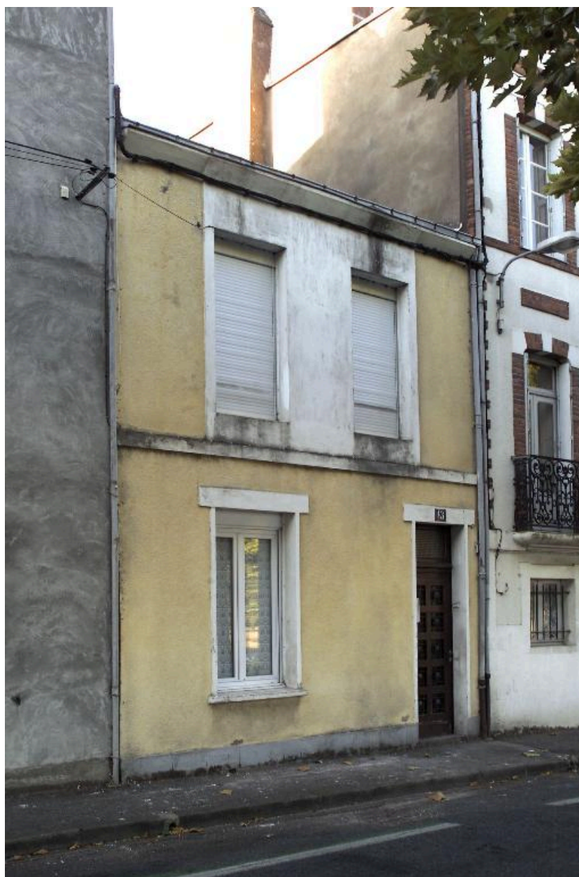
La façade antérieure de la maison n° 13 quai Gautreau.
