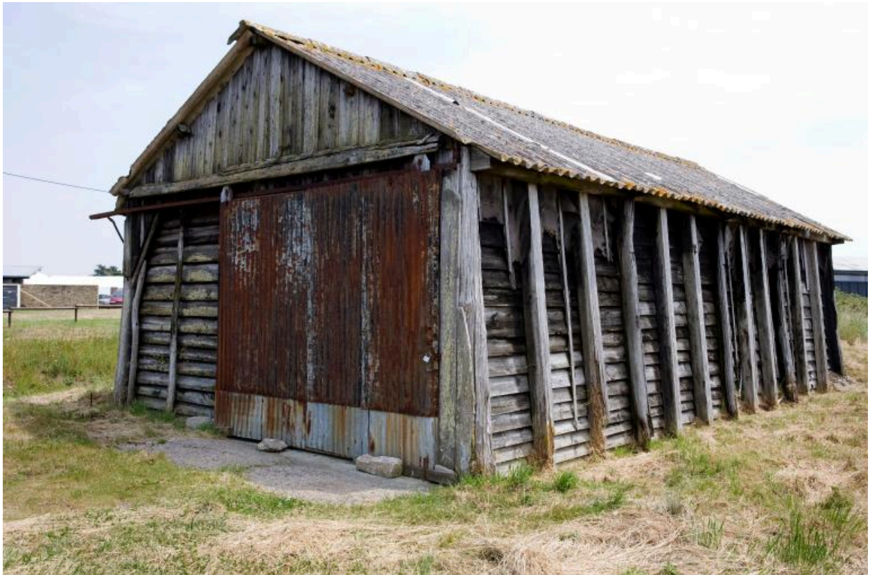
Entrepôt ou magasin à sel en bois construit sur la saline les Chevaliers à proximité de Pradel.
