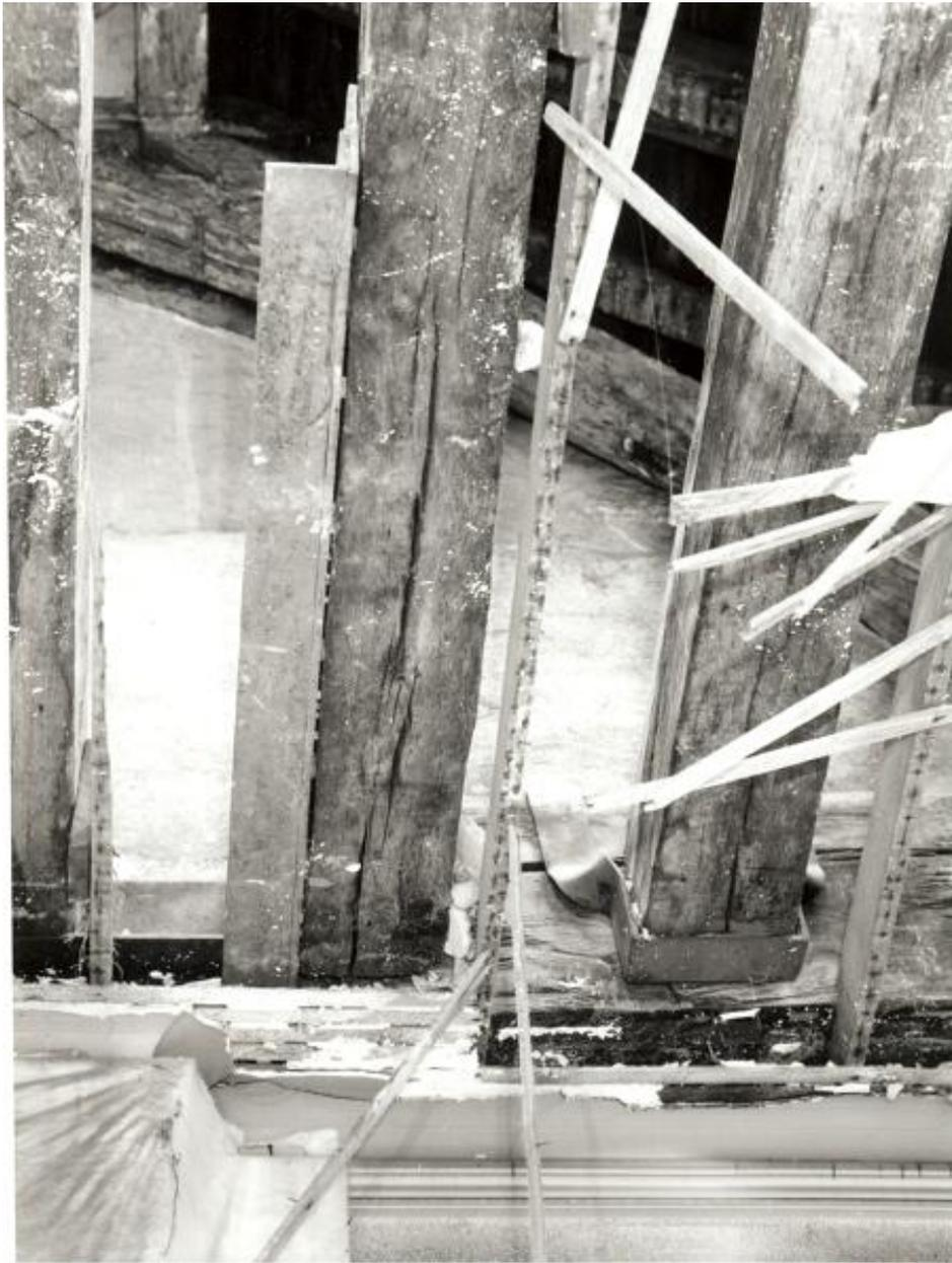
Corps principal, 1er étage, pièce extrême gauche (est), contreplongée sur le plafond, à droite et au-dessus de la cheminée : poutre sectionnée par un mur de refend à la fin du 19e siècle ; travaux de restauration, 1997-1998.
