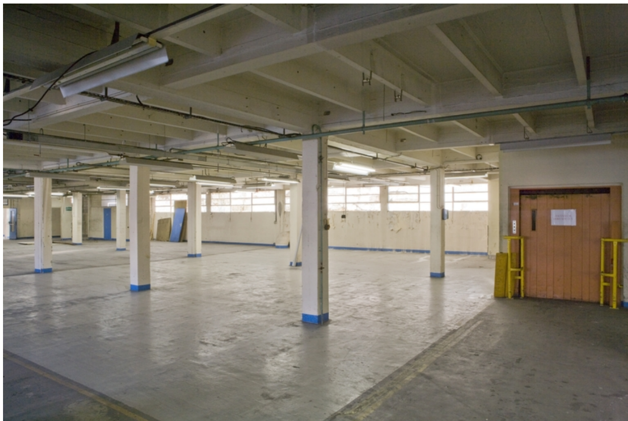
Atelier de fabrication 1, 1er étage.
