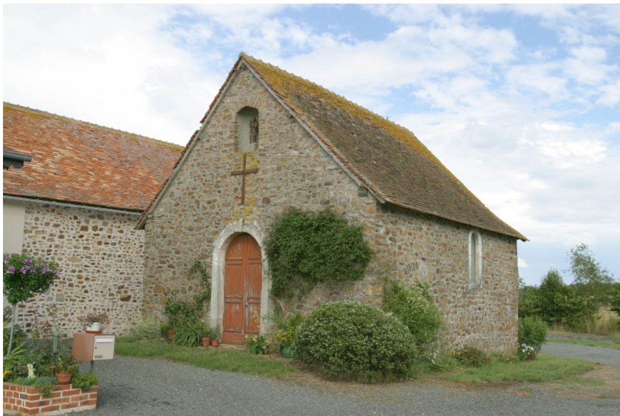
Vue depuis l'ouest : façade, élévation sud.
