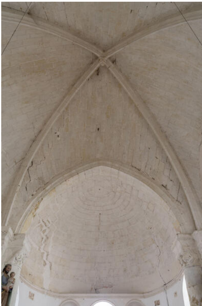
Voûtes du chœur et de l'abside.
