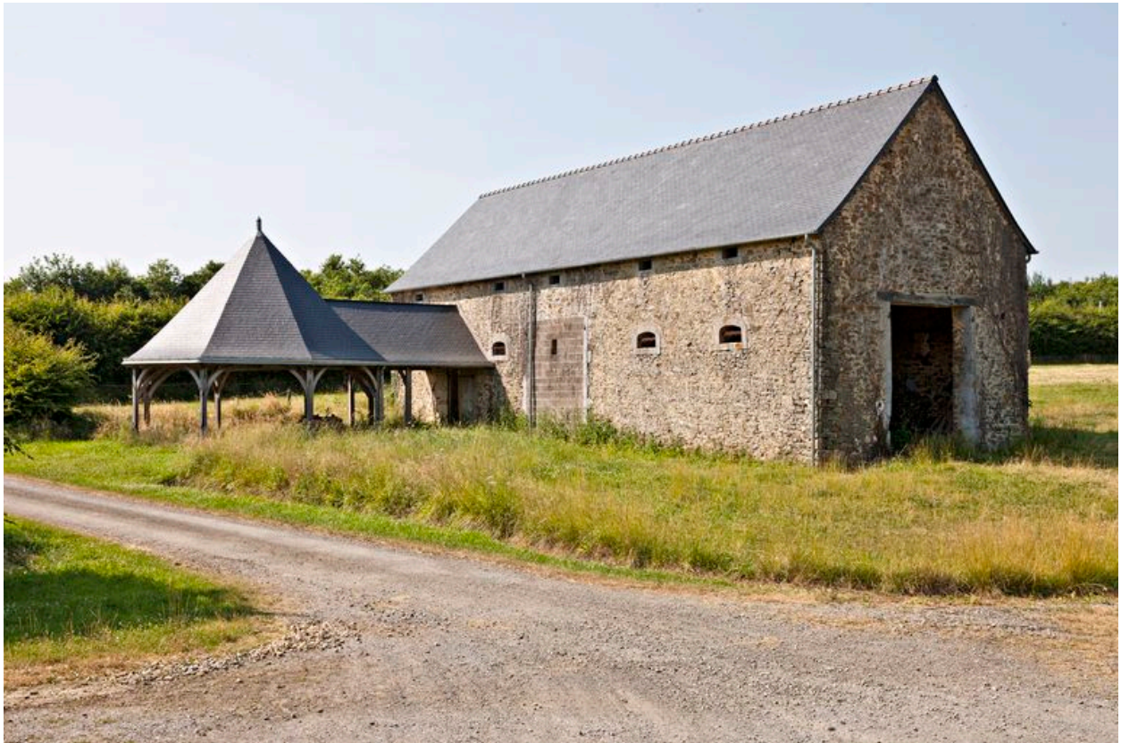
La remise vue depuis la cour au sud.
