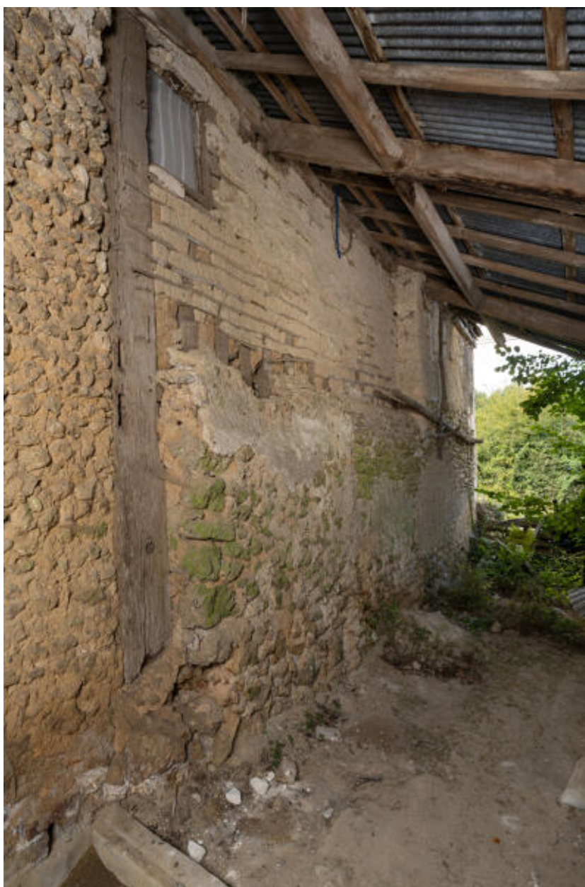
Arrière du logis à étage : pan de bois.
