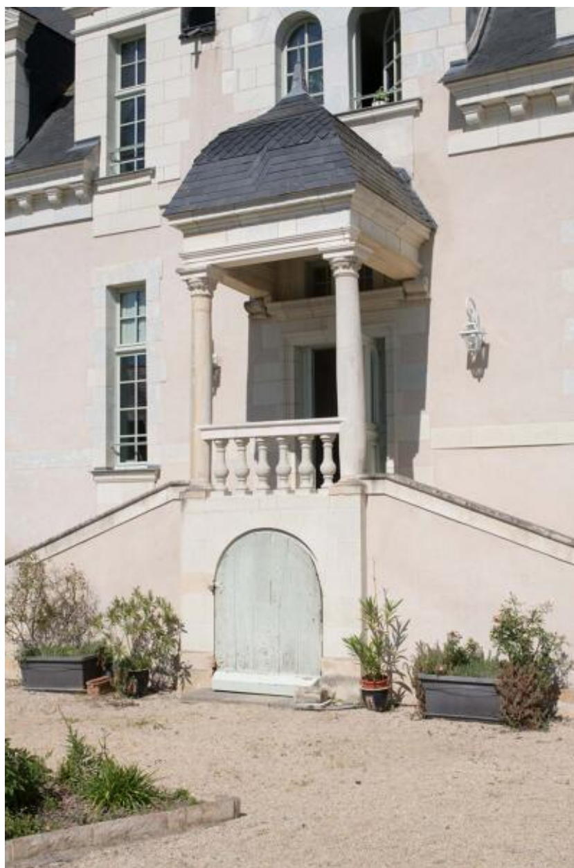
Détail de l'escalier extérieur central à montées convergentes.
