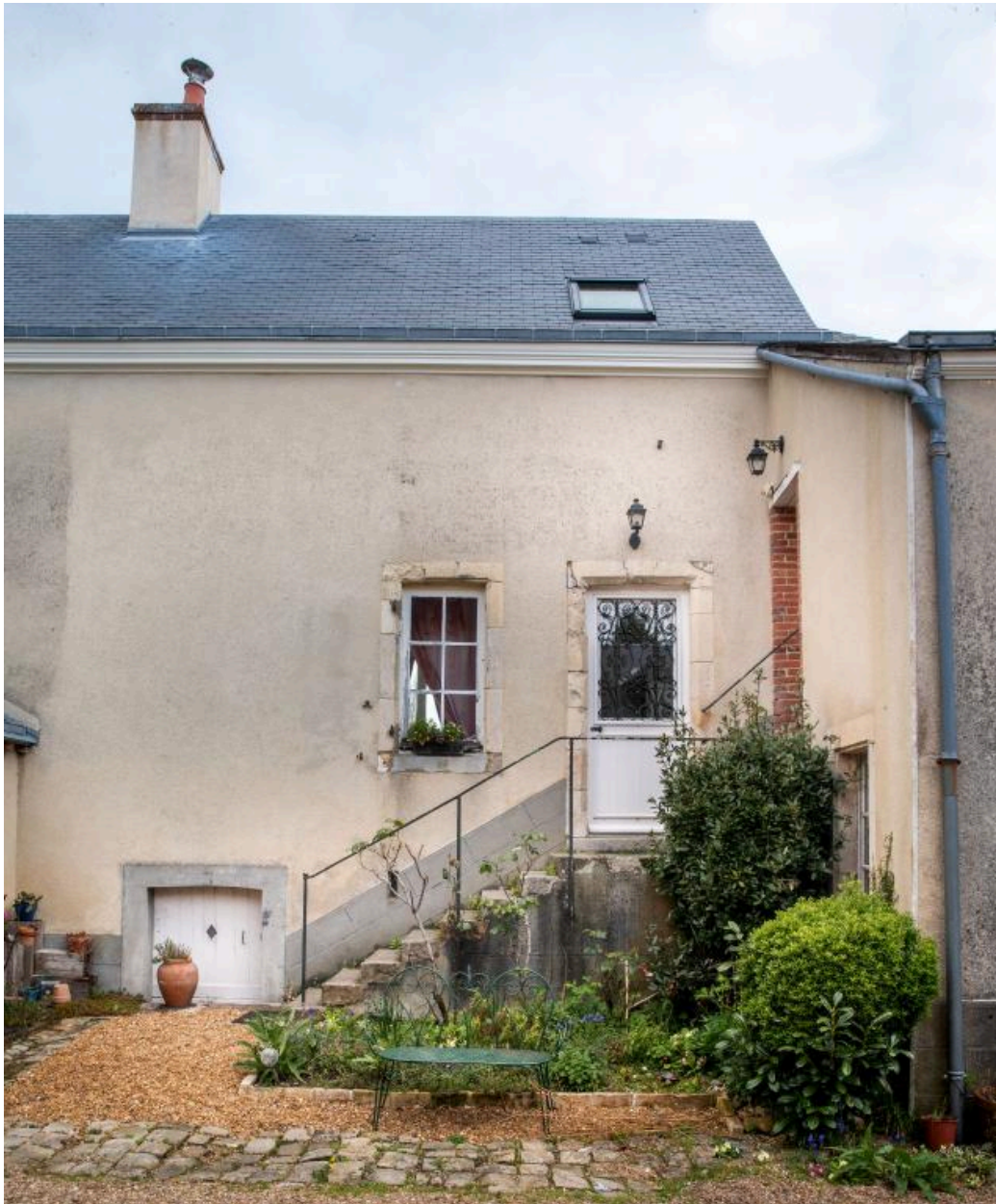
L'escalier et la porte chanfreinée.
