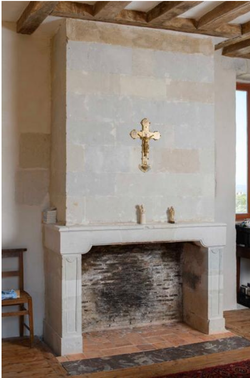
Détail de la cheminée de la chambre sud-est.
