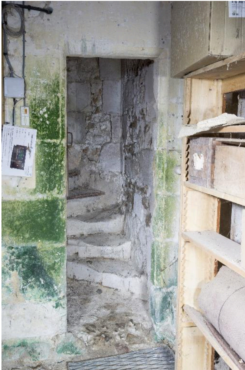
Intérieur, chapelle 1 : baie ouvrant sur l'escalier en vis dans la tourelle.
