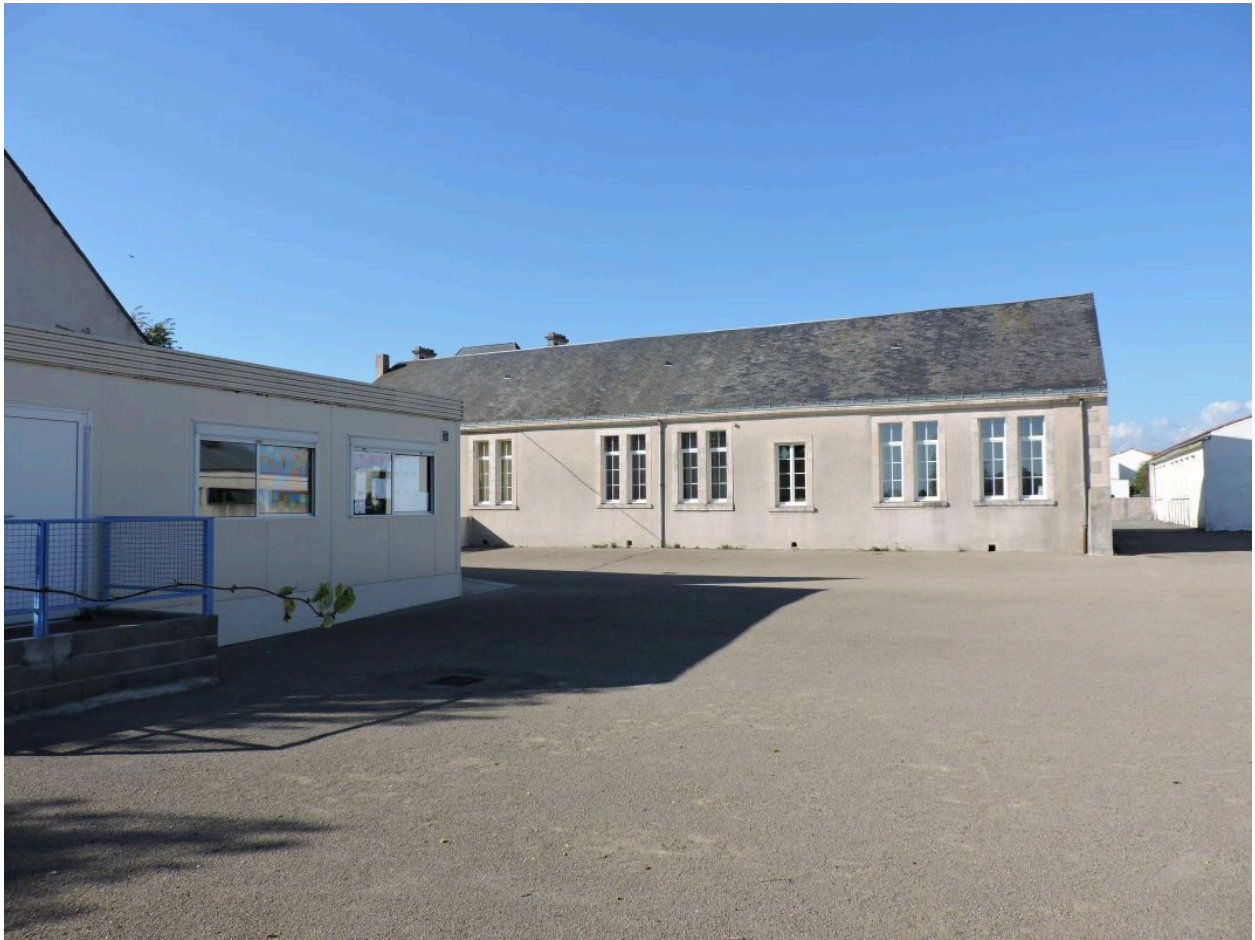
La cour sud et le bâtiment de salles de classes de l'ancienne école de garçons, vus depuis le sud.
