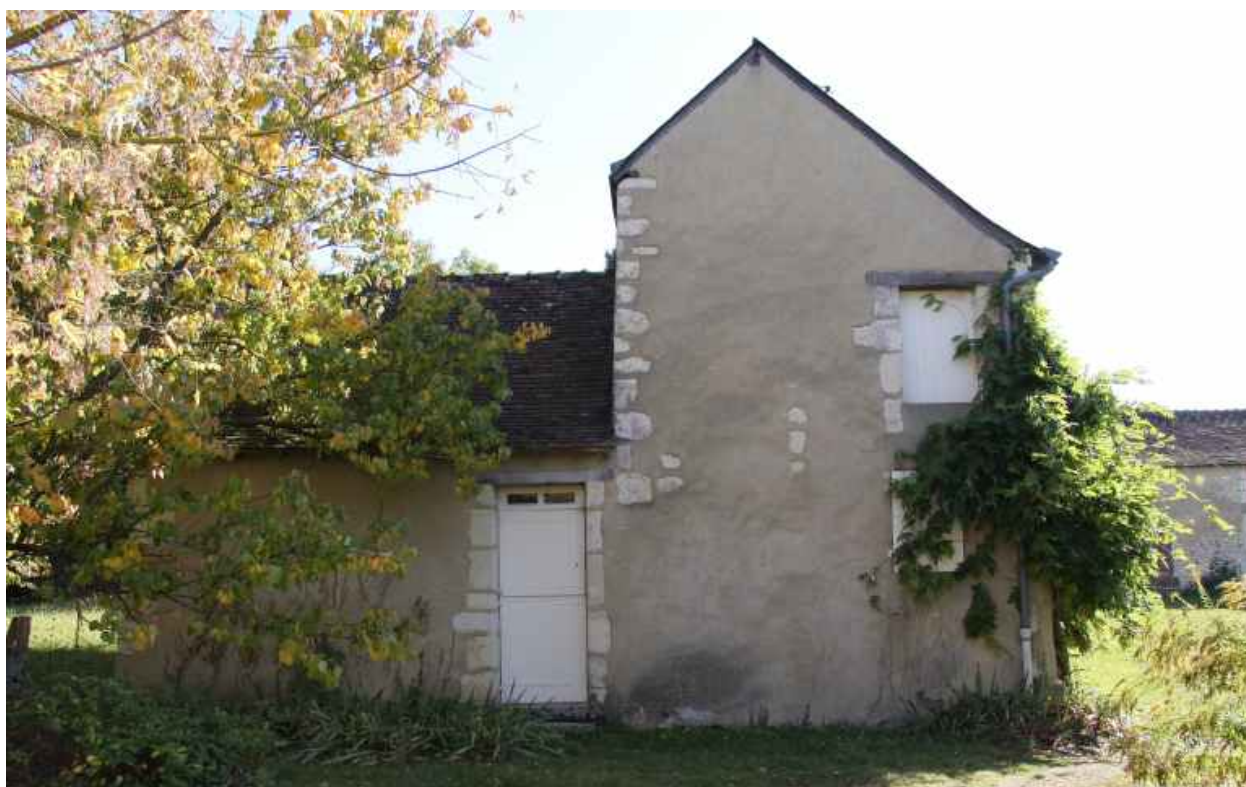
Maison 1 : pignon nord.
