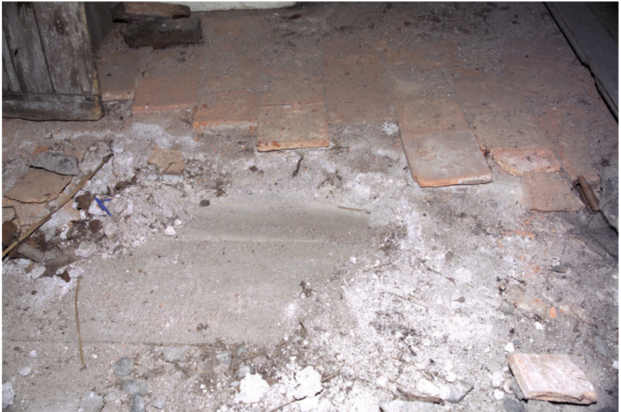
La pièce située au premier étage, détail du pavement.
