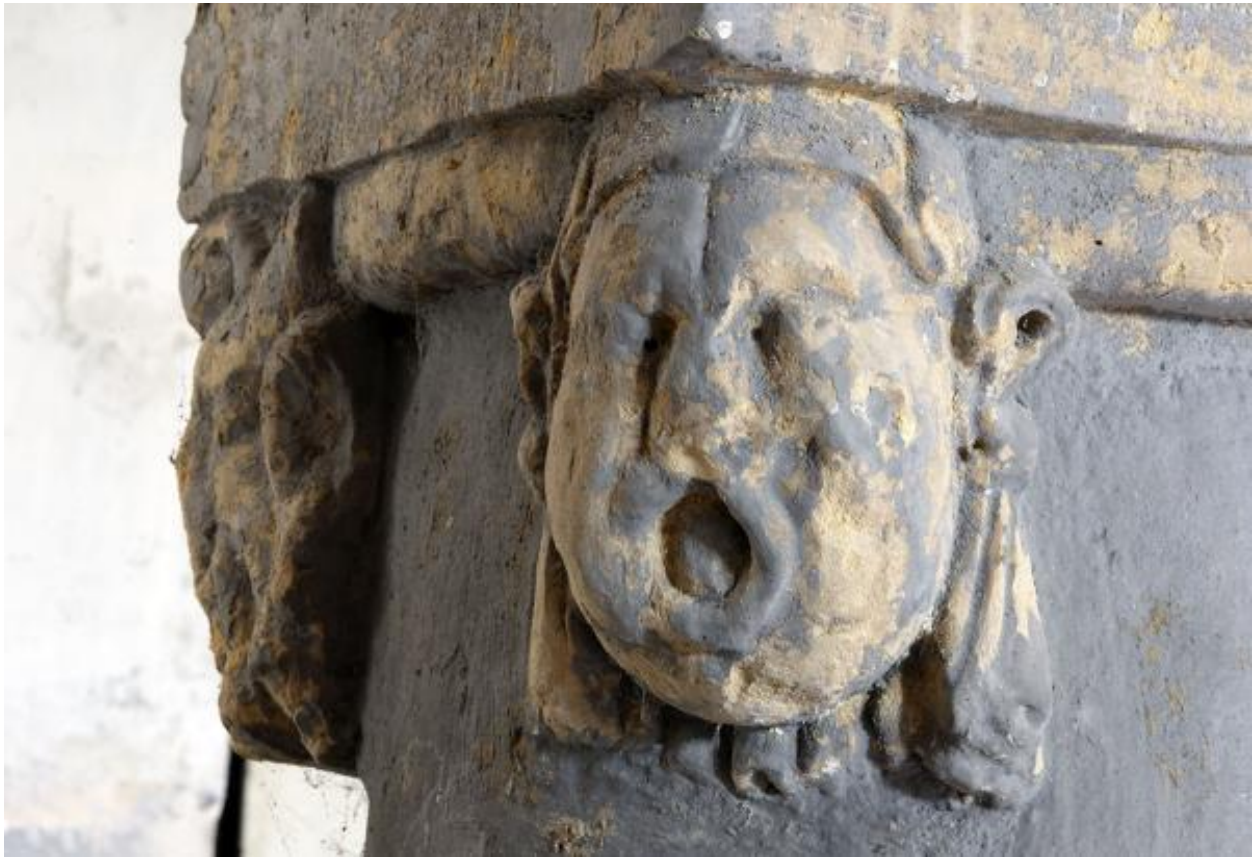
La cuisine en sous-sol, détail d'une colonne sculptée.
