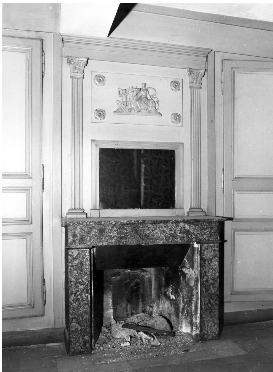
2e étage, pièce antérieure, mur droit.
