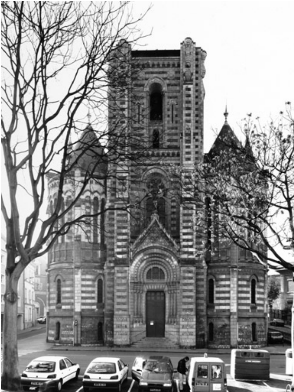
Façade antérieure (nord).
