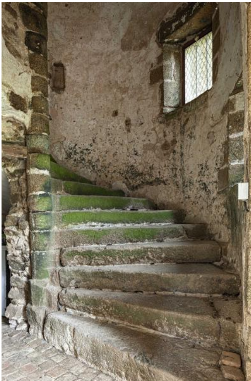
Escalier du corps de logis sud.
