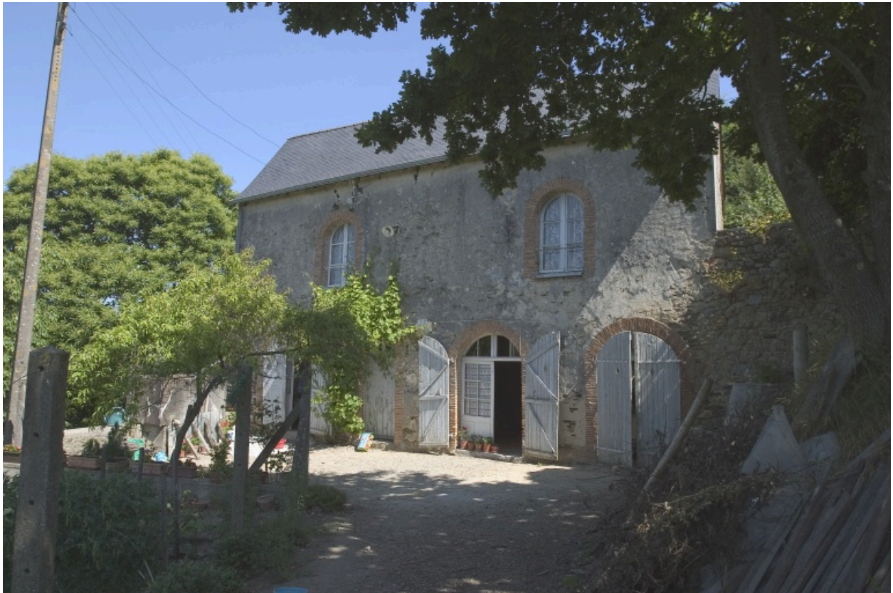
La façade principale vue depuis le sud.
