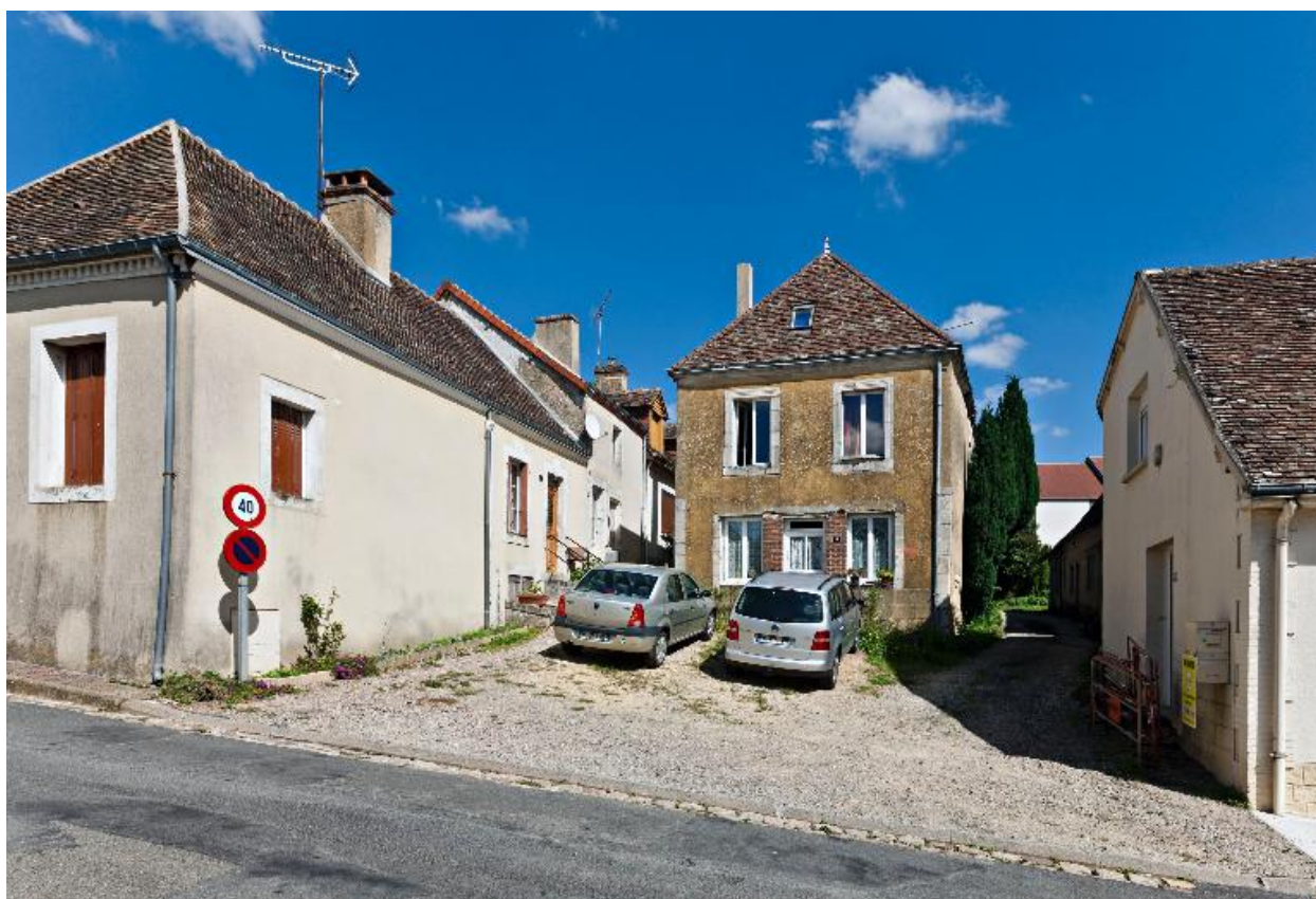
8-14, rue Basse. Vue générale de l'ensemble d'édifices à cour commune.
