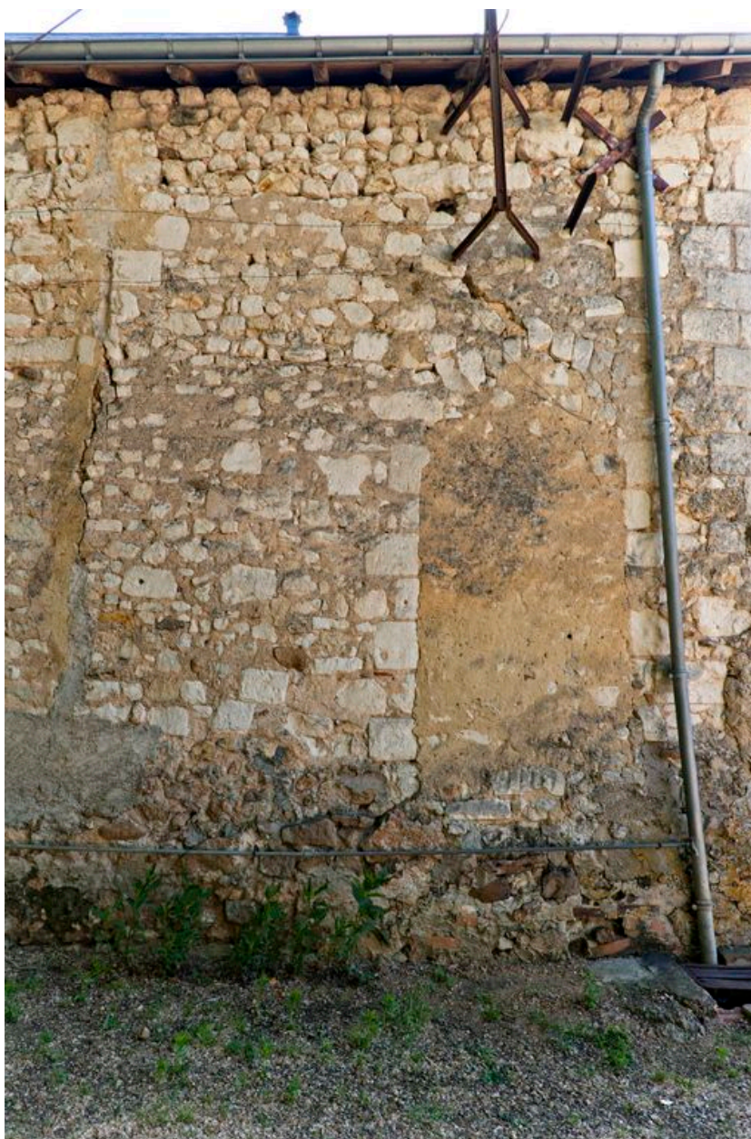
Façade occidentale, détail : ancienne porte d'entrée couverte d'un arc brisé.
