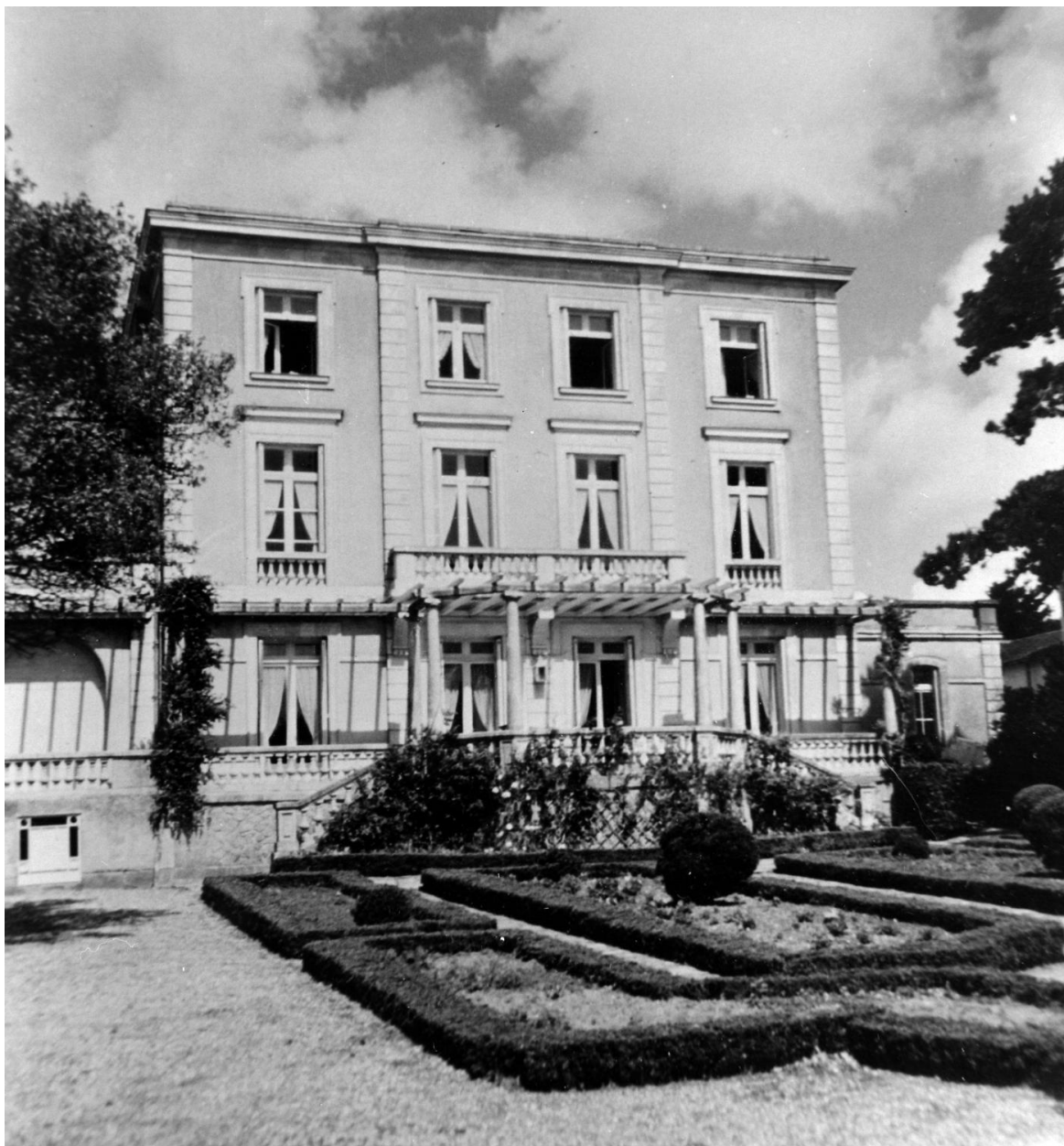
Elévation sud. Photographie, [s.d.].
