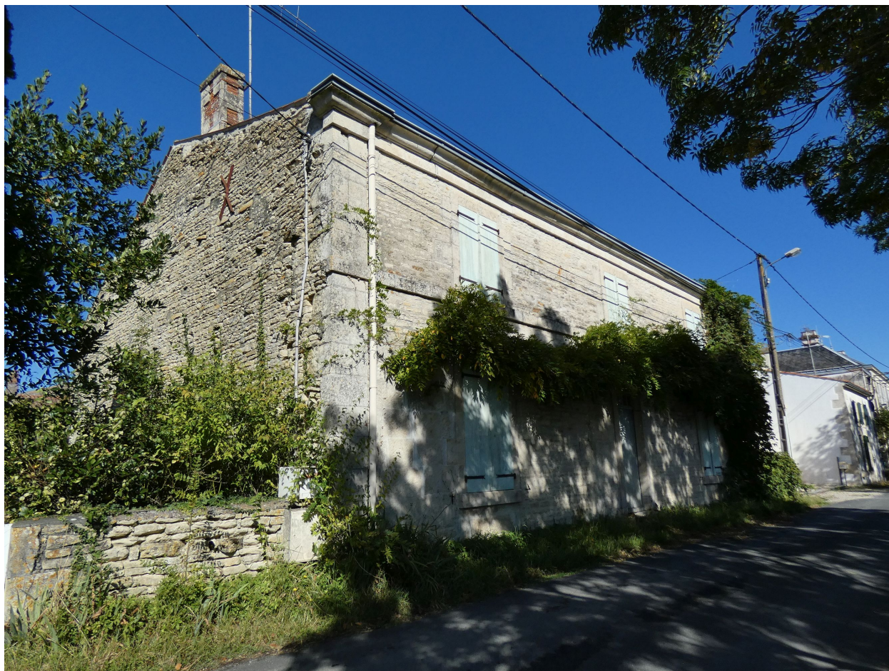
Le logis vu depuis l'ouest.
