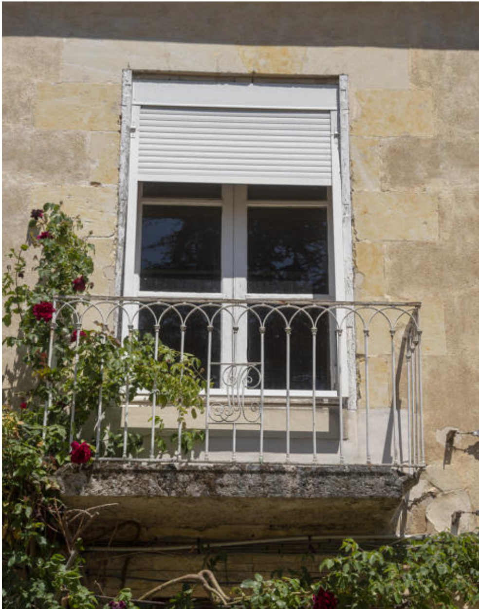
Détail du garde-corps du logement patronal A1 de l'usine de papeterie.
