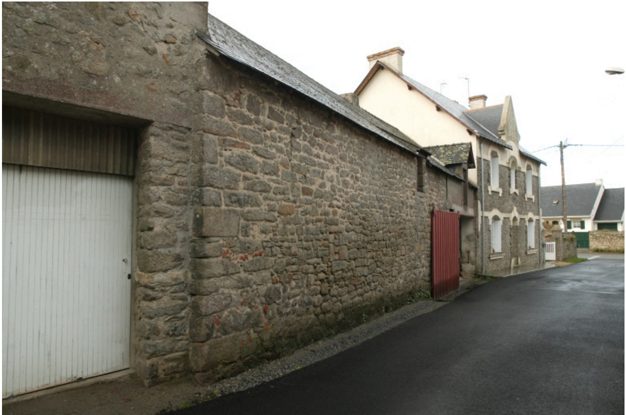
Vue de la maison depuis le chemin Thobie (au premier plan).
