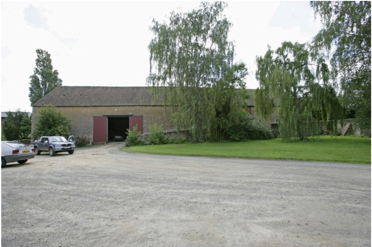
Grange-étables : élévation sur cour.
