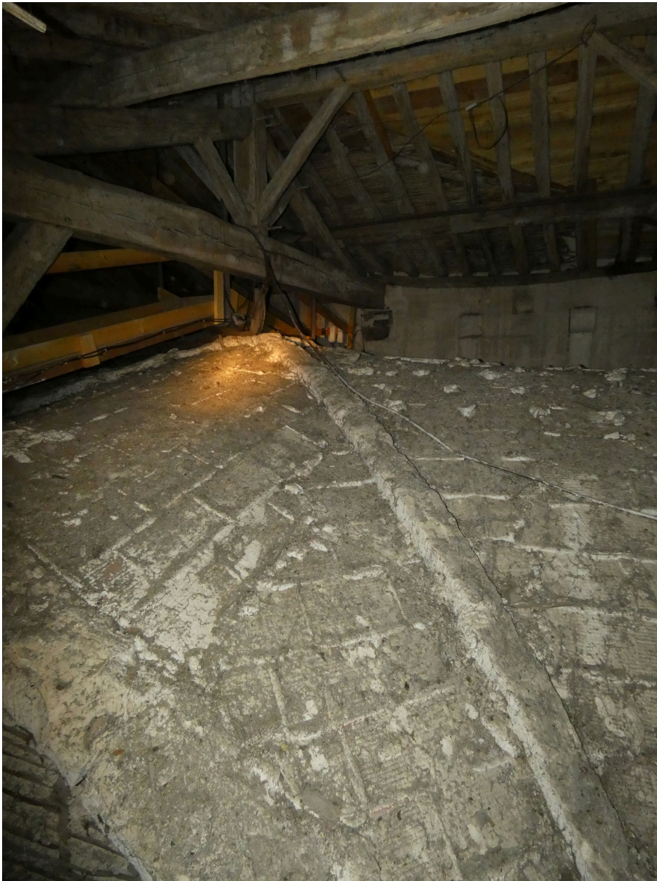
Voûte en briques au-dessus de la nef.
