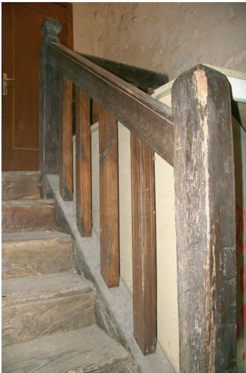
Bâtiment des greniers : escalier tournant en bois (XVIIe siècle ?)
