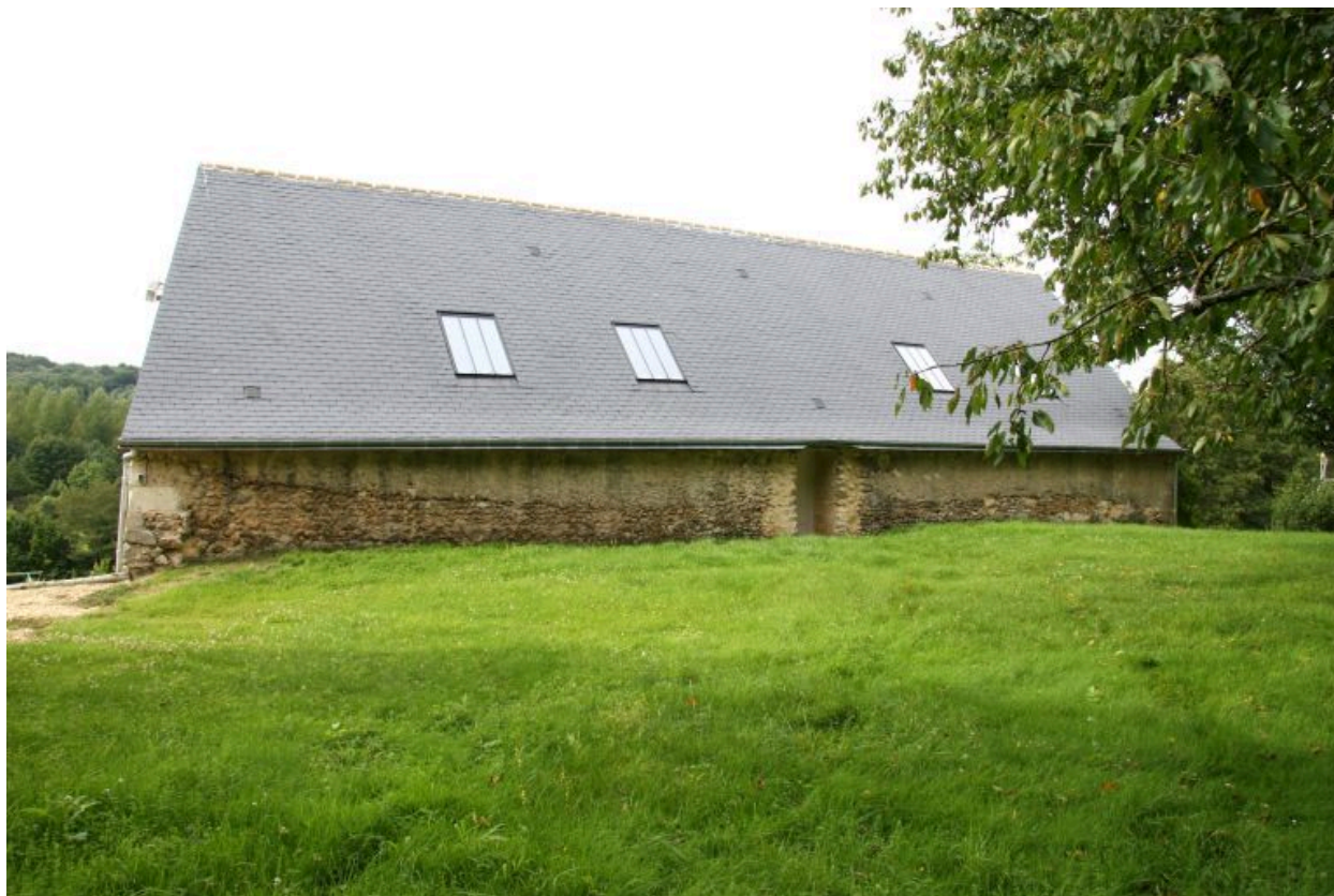
Logis 2 : façade nord semi-enterrée.
