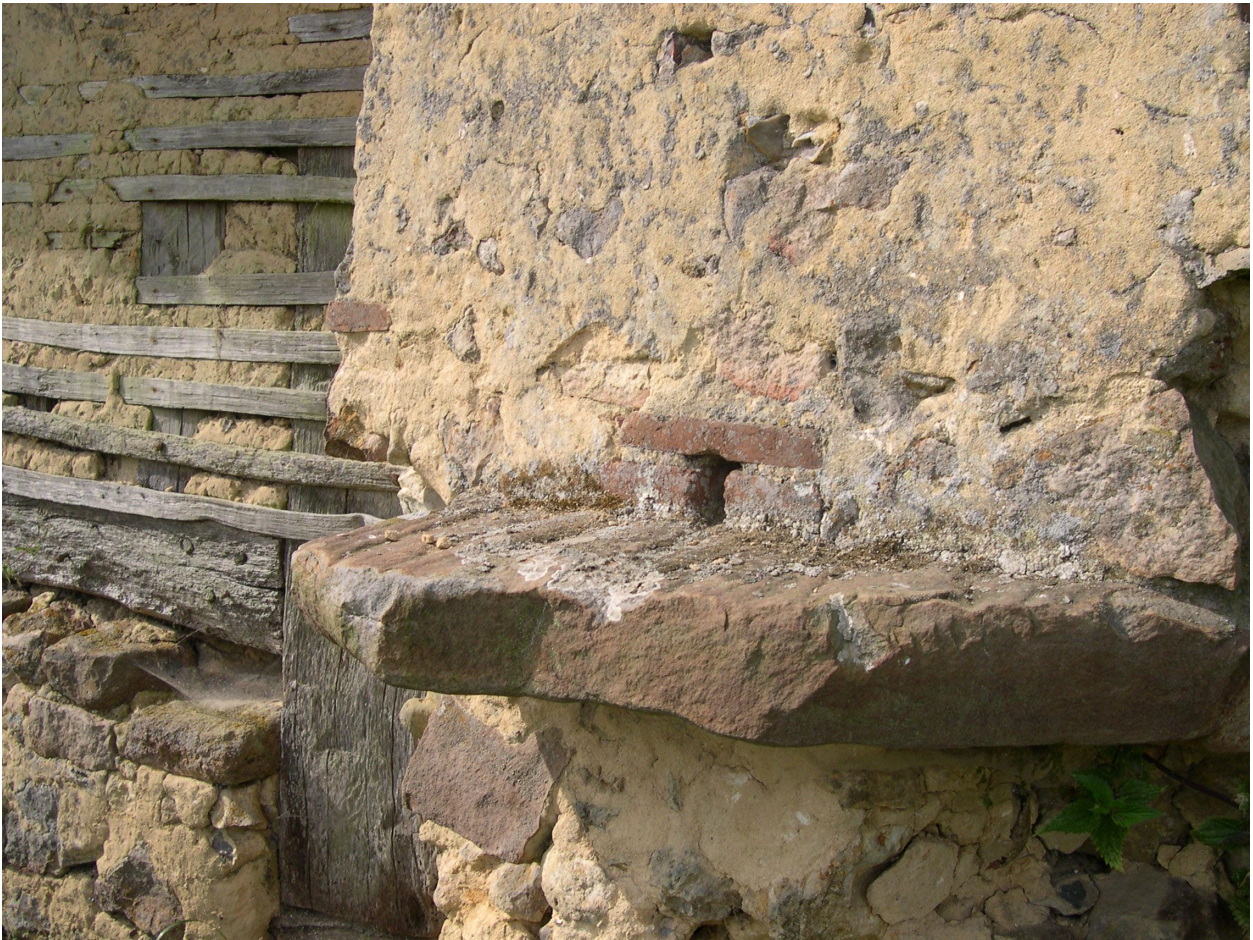
Détail de l'élévation postérieure du logement : égout de l'évier (état en 2003).
