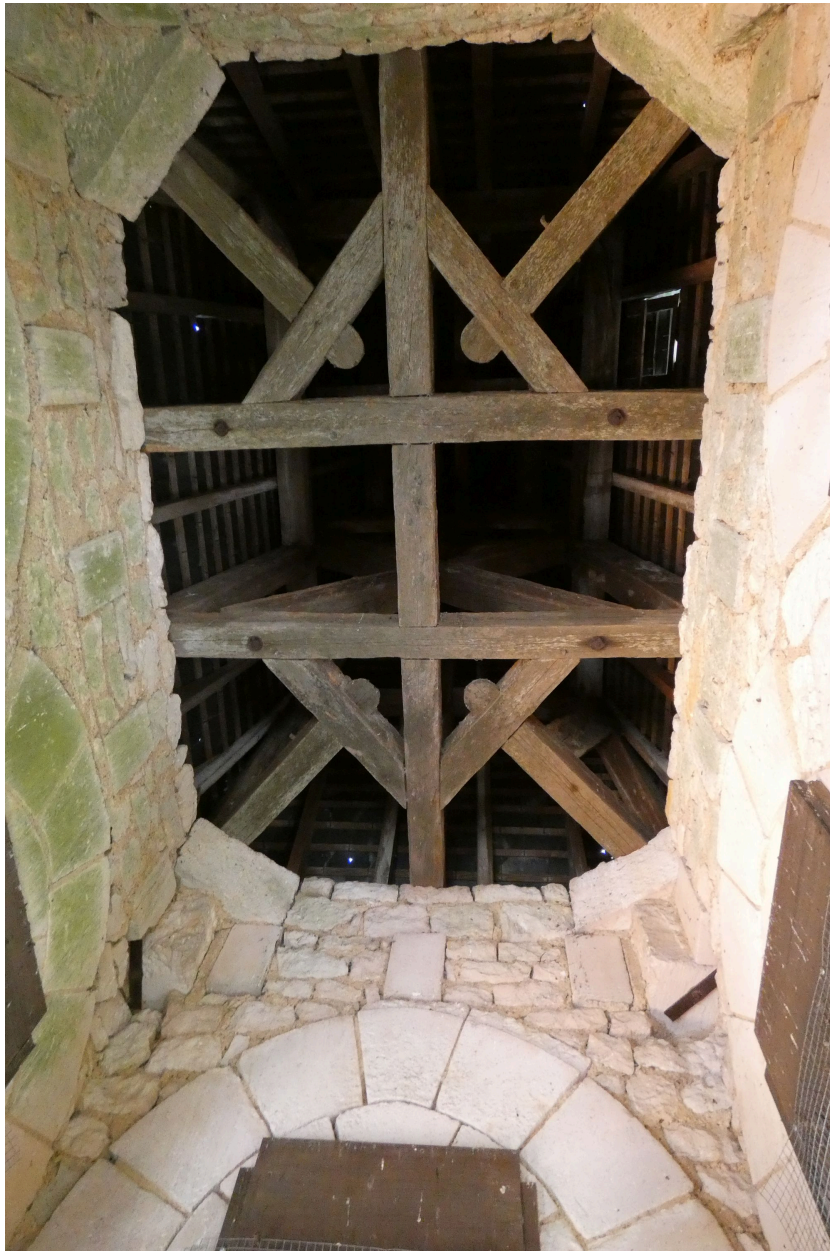
La charpente du clocher.
