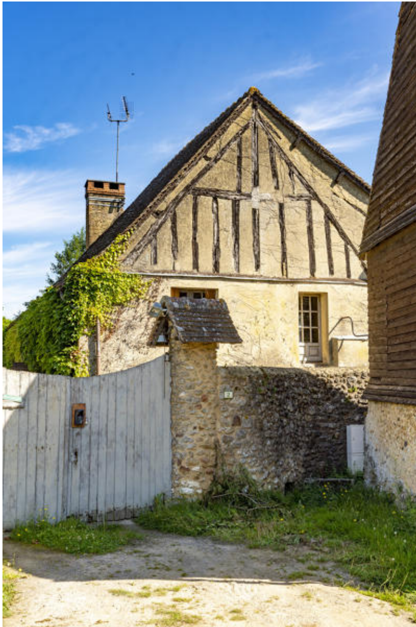
Vue du bâtiment usine du moulin de Cherruau.
