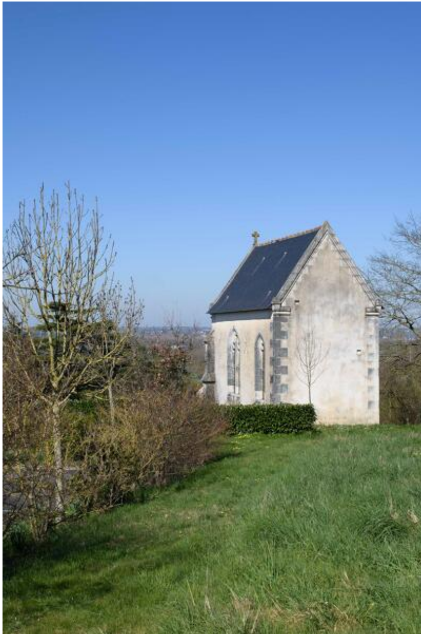
Vue de la chapelle depuis le sud.
