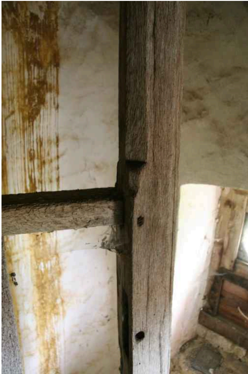
Escalier en vis, poteau du garde-fou : détail.
