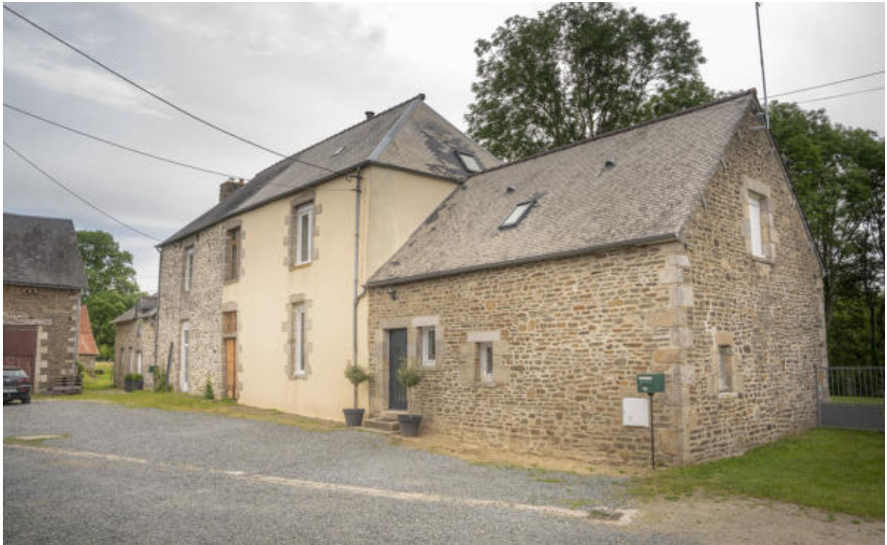
La façade antérieure de la maison, côté cour.
