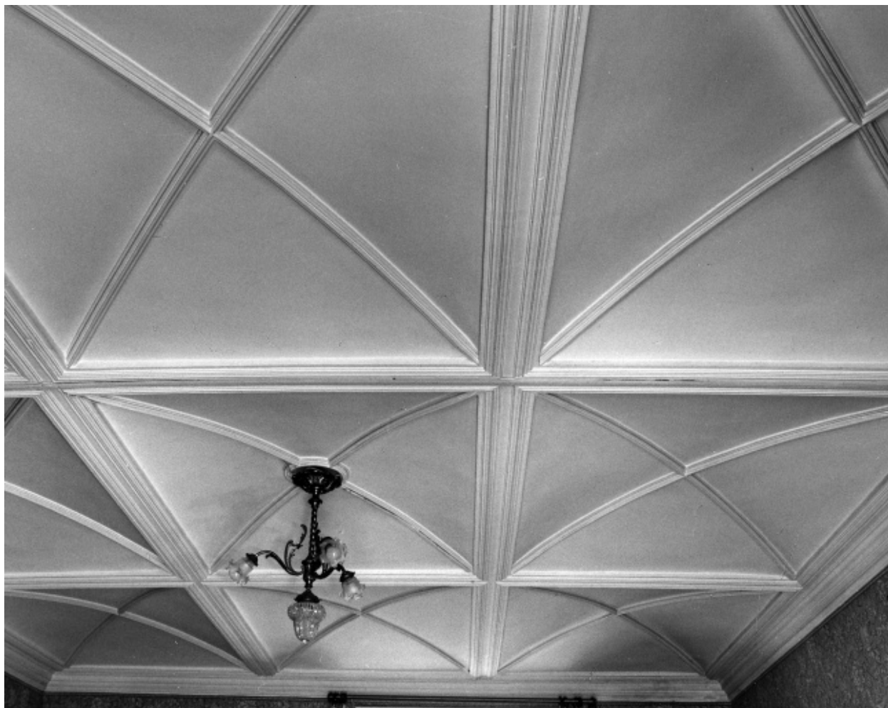
Corps de logis principal, grande salle du rez-de-chaussée : plafond.
