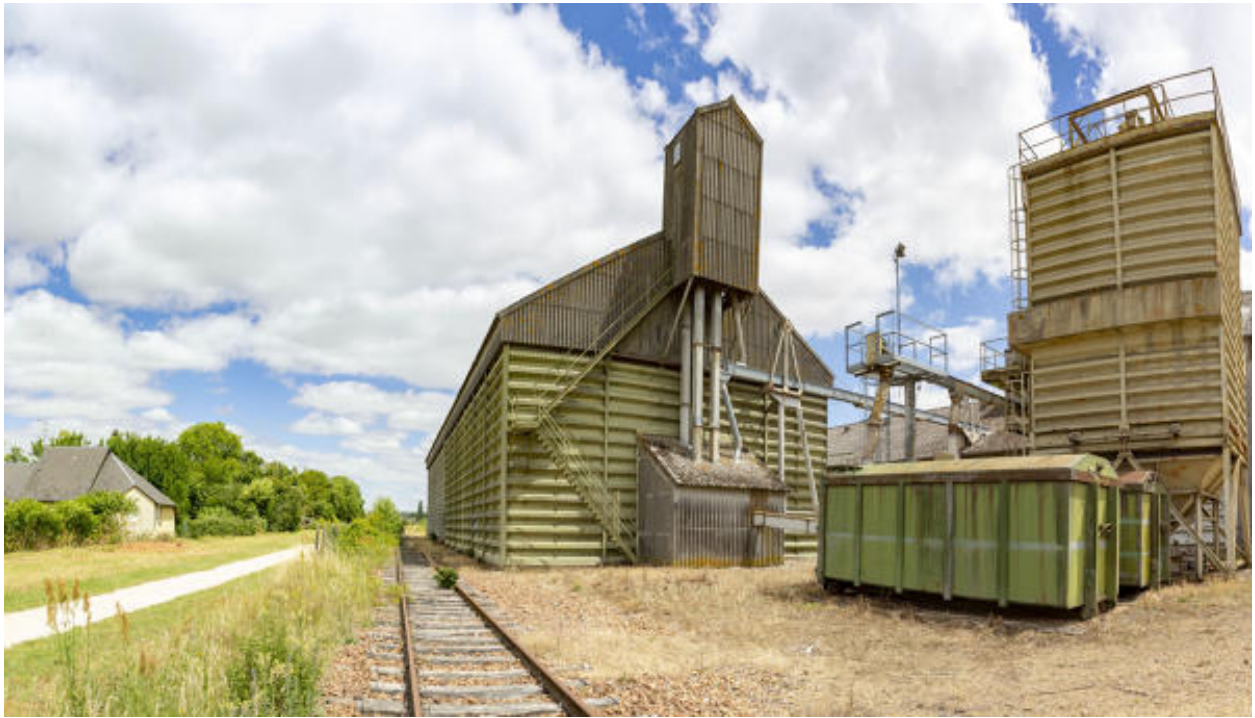
Les silos de la coopérative agricole.
