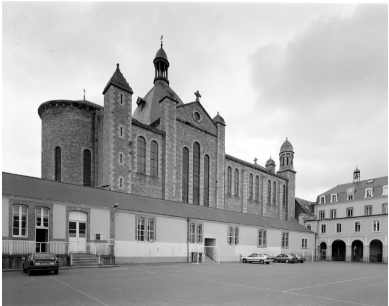
Façade latérale ouest : vue d'ensemble depuis la cour.
