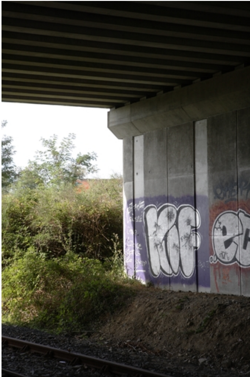
Poutres, bossages, chevêtre et pile.
