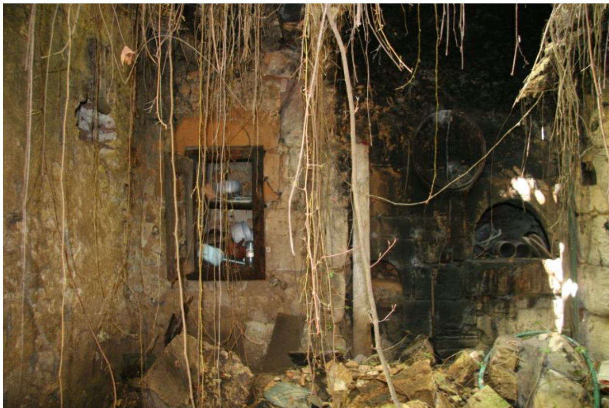
La chambre principale : niche-placard à gauche de la cheminée.
