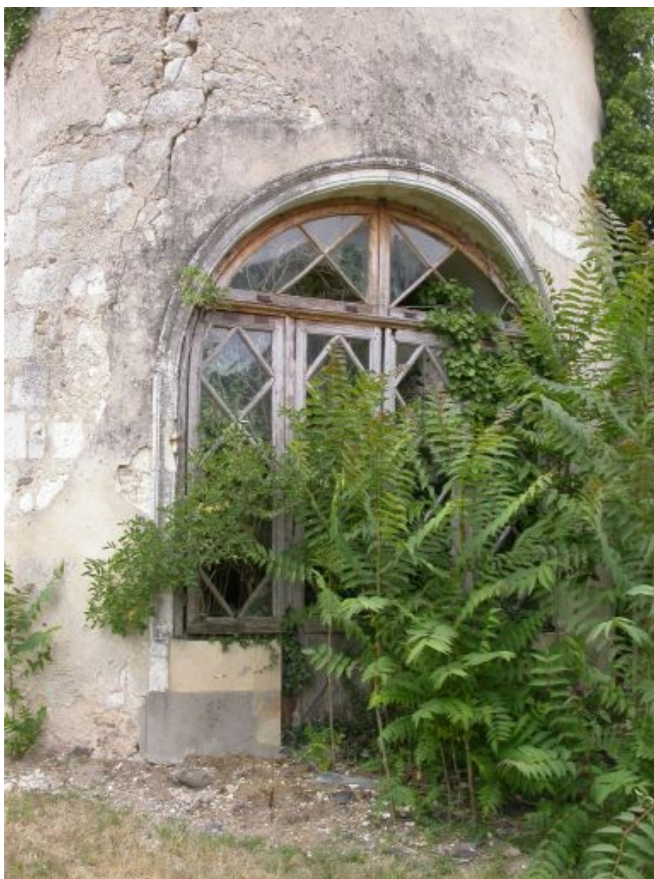
Tour d'angle de l'ancien château : menuiserie d'orangerie.
